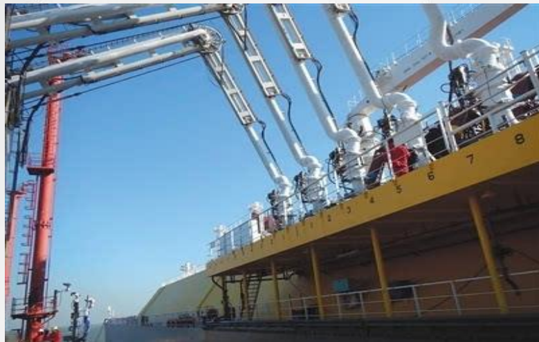
曹妃甸液化天然气运输船的卸料臂
